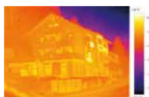
Wärmebild ohne testo ScaleAssist
