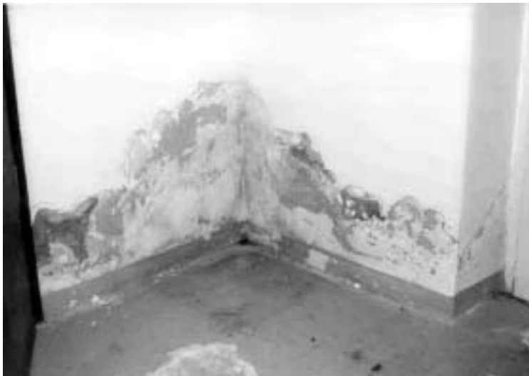
Abb. 25: Feuchteschaden-Beispiel
